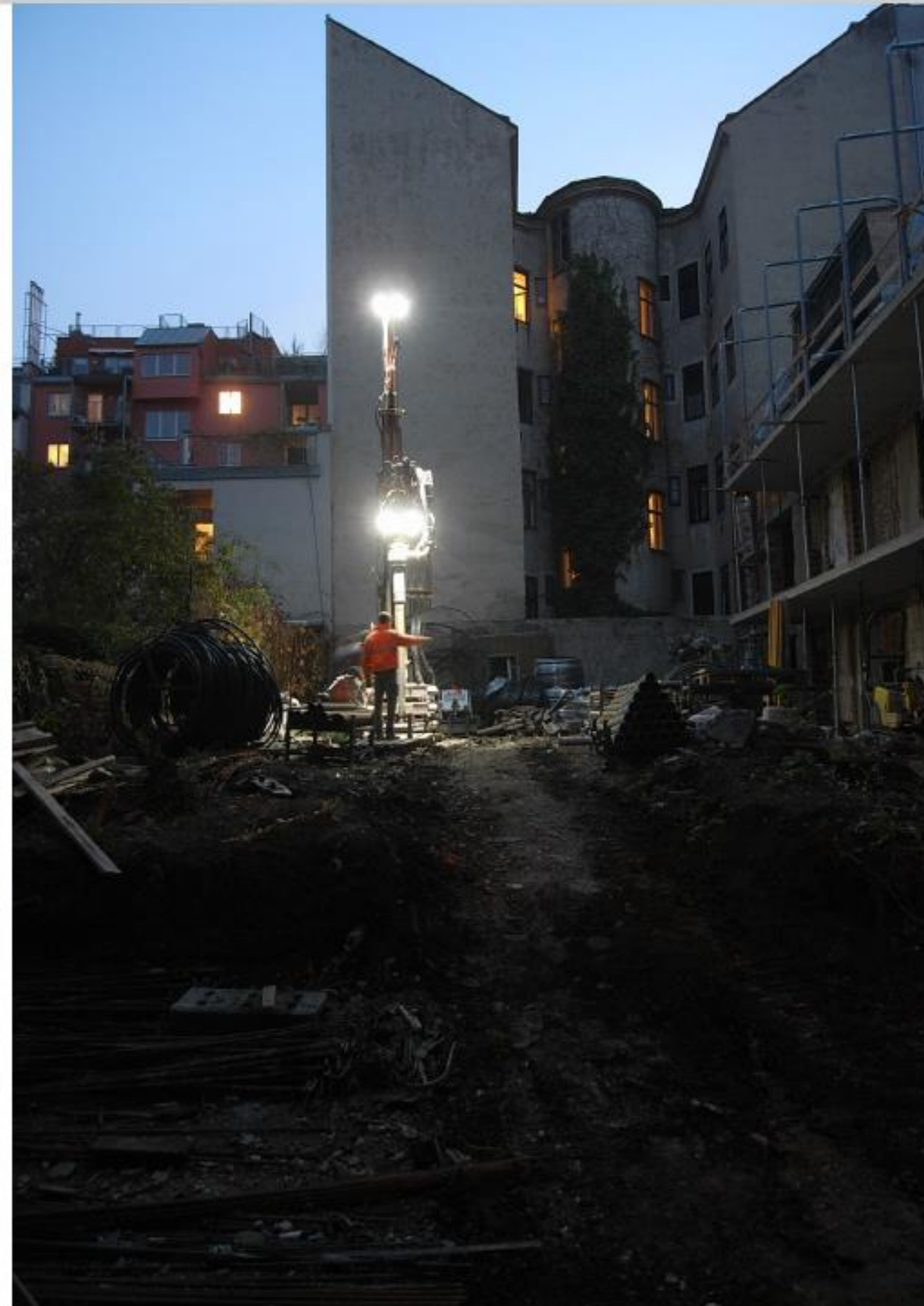
... die Geothermie-Speicherbatterie wird gebohrt
