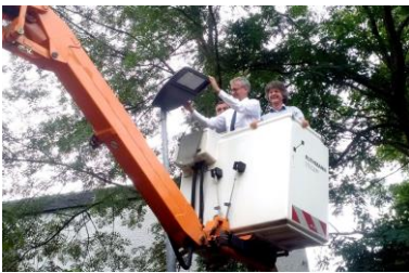
Minister Al-Wazir und Bürgermeister Dr. Kahle bei der Montage einer LED-Leuchte am Ortenbergplatz in Marburg
