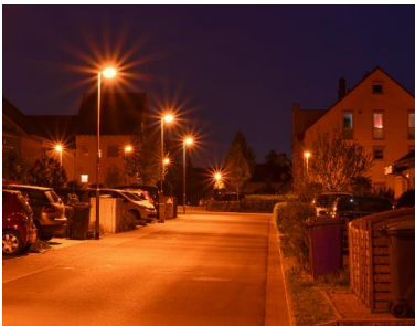
Beleuchtungssituation im Achstatttring vor der Modernisierung
