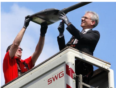
Minister Al-Wazir montiert eine LED-Leuchte in Gießen-Allendorf
