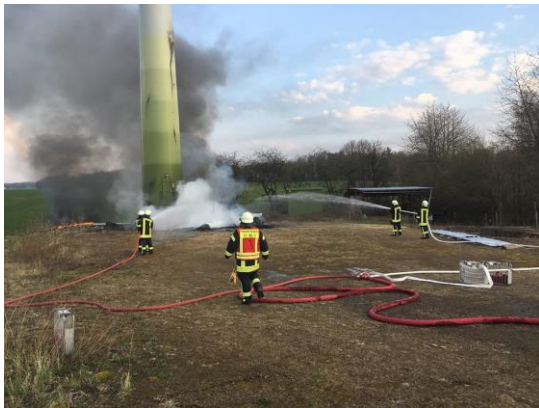
Abbildung 2: Brandbekämpfung von herabgefallenen Rotorblättern an einer Anlage bei Frohburg (Landkreis Leipzig) am 11.04.2018. Quelle: Freiwillige Feuerwehr Frankenhain-Frohburg
