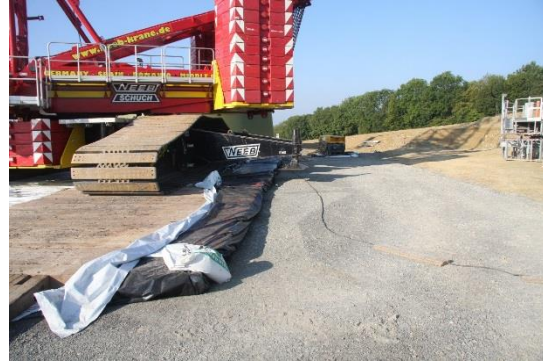
Abbildung 5: Ausgelegte Folie zum Gewässerschutz auf Baustellen; Quelle: BGU
